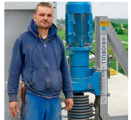
Michael Ullrich vor seiner ergänzten Anmischgrube mit Rührsystem. Foto: Jens Rückert
