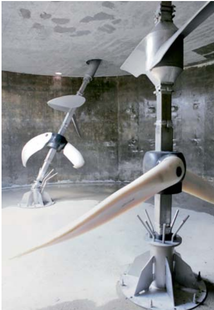
Langsam laufendes Rührsystem Hydrobull
