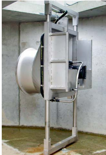
Ein Zwangsmischer im leeren Behälter
